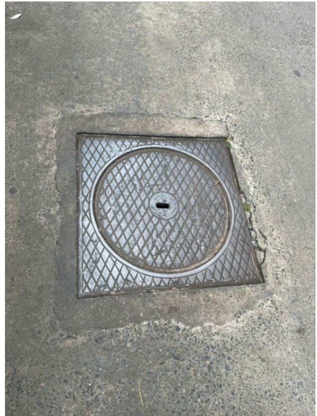
b) Hố ga thoát nước mưa
