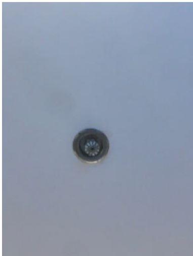
Đầu chữa cháy tự động Sprinkler
