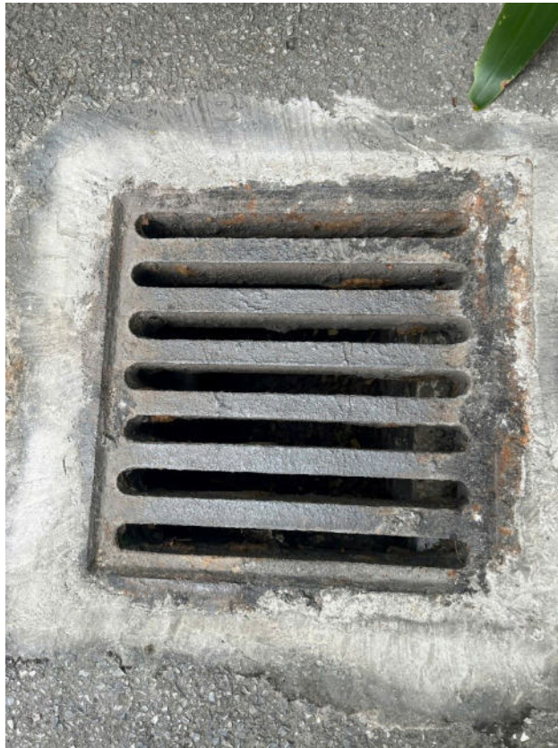
a) Rãnh thu nước mưa
