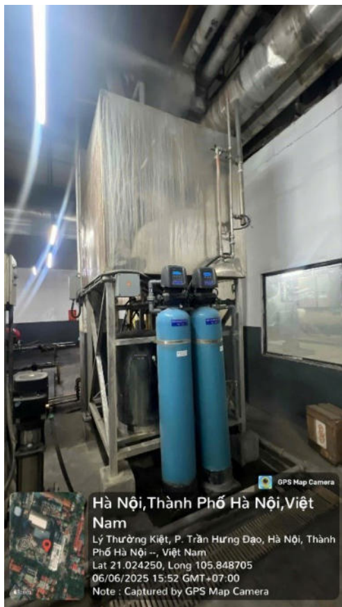
Lò hơi (BEEL - UK) công suất 960KG/hr (dùng cho hệ thống giặt là)
