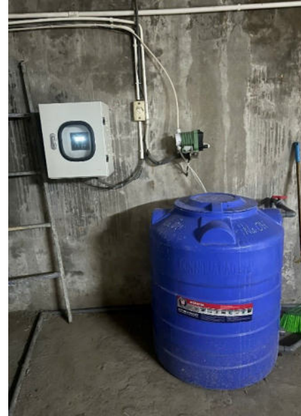
Bồn dinh dưỡng và hóa chất khử trùng
